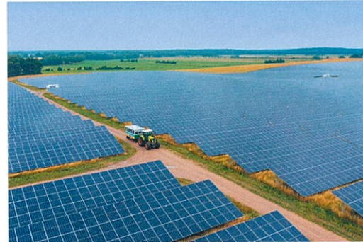
チントのn型パネルは世界中で続々と採用されている。写真は2023年4月にドイツで稼働した154.4MWの太陽光発電所
